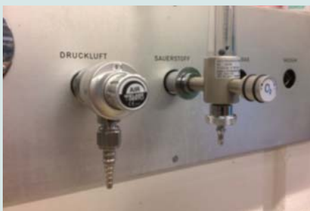
Druckluftspender mit Fest-Wert und Sauerstoffspender regelbar
